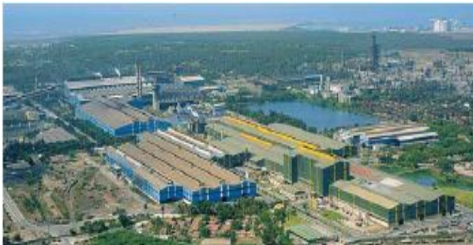
Essar Hazira steel plant.
